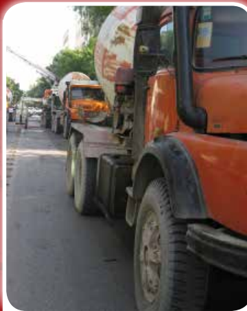
بتن ریزی دیوار حایل
