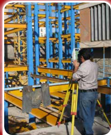
تراز ستون های پارت سوم با دستگاه توتال
