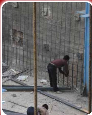
آرماتور بندی دیوار حایل
