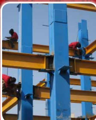
عملیات جوشکاری تیرها و ستون های پارت سوم
