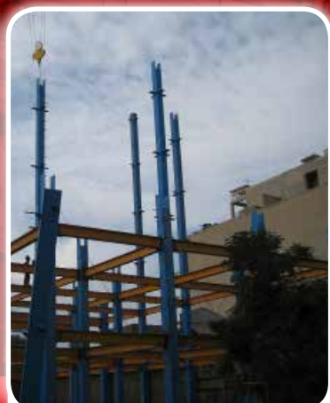
عملیات نصب ستون های پارت سوم
