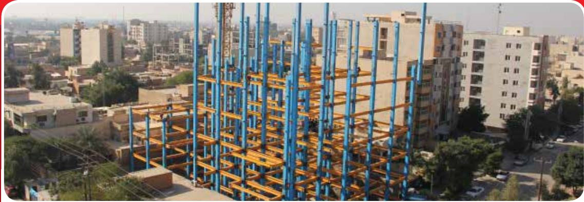
نمایی کلی از اسکلت فلزی ساختمان در حال احداث اتاق اهواز
