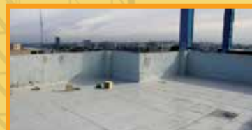
اتمام شیب بندی، عایق کاری و کف سازی پشت بام ها
