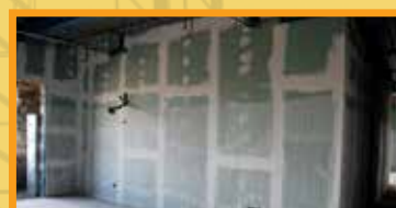
تکمیل دیوارهای کناف و اجرای زیرسازی رنگ آمیزی دیوارها
