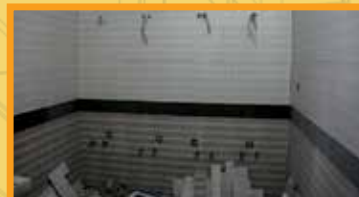
اجرای کاشی کاری بدنه سرویس بهداشتی
