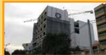
اجرای پلاستر نمای ضلع غربی
