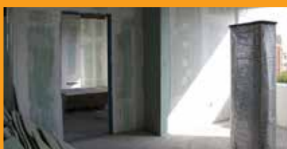
ماسטיک و بتونه کاری دیواره های کناف جهت رنگ آمیزی
