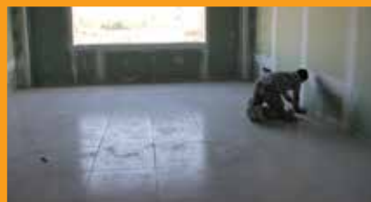
شروع عملیات سرامیک پرسلانی کف
