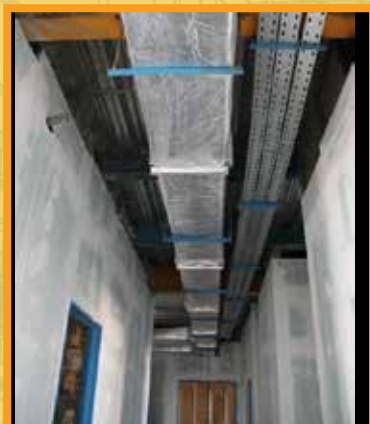
تکمیل عملیات نصب کانالهای تهویه مطبوع و سینی کابل ها
