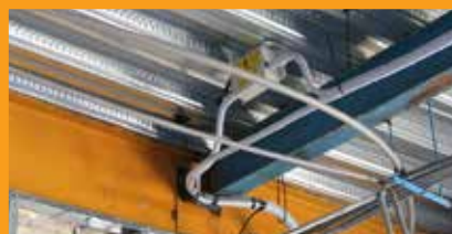
اجرای لوله گذاری سیستم سرمایش و گرمایش
