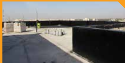
اجرای عایق کاری دیواره جان پناه
