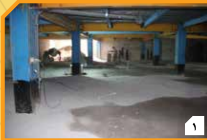
۱ اتمام عملیات کف سازی و پارکینگ زیرزمین دوم
