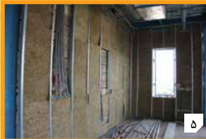
۵ تکمیل عملیات عایق کاری با پشم سنگ و اجرای دیوار های کناف
