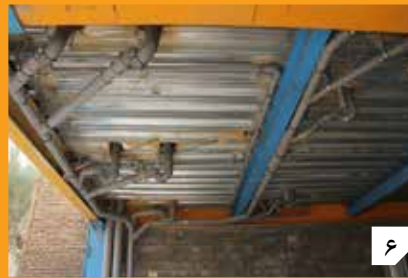
۶ تکمیل عملیات لوله کشی فاضلاب و آب باران طبقات
