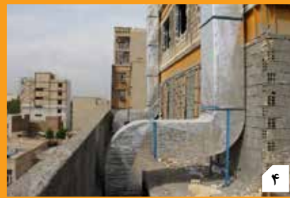
۴ تکمیل کانال های تاسیساتی تهویه مطبوع سیستم سرمایشی و گرمایشی
