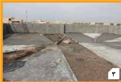
۳ اجرای عایق حرارتی و پوکه ریزی و شیب بندی پشت بام
