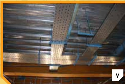
۷ ادامه اجرای عملیات لوله کشی برق و نصب سابلورت سینی کابل های برق در طبقات
